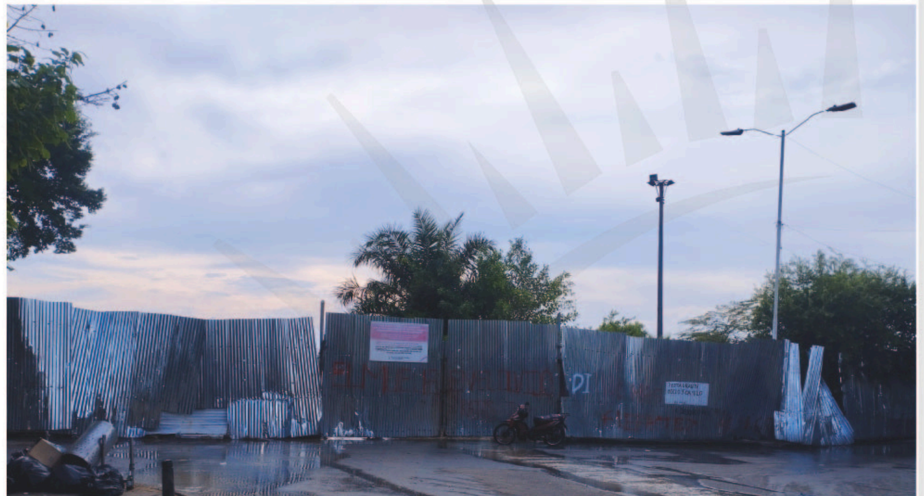
Lote del Muelle Fotografía tomada por Angely Valdelamar Jiménez (2026).
