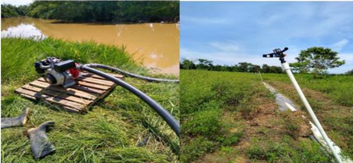
Imagen 28. Estación de bombeo e instalación de aspersores en el banco de proteínas
