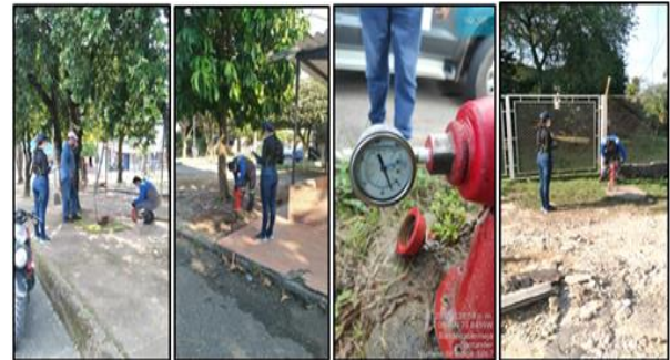
Figura 3. Pruebas de presión en los hidrantes
