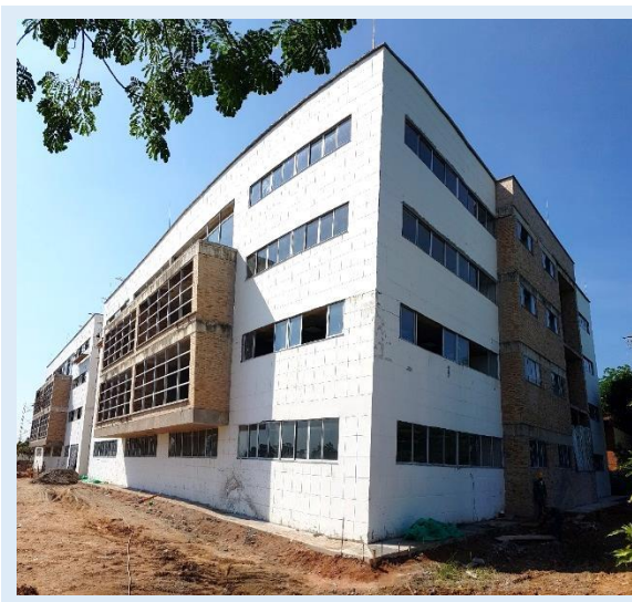
Figura 44. Edificio de aulas.
