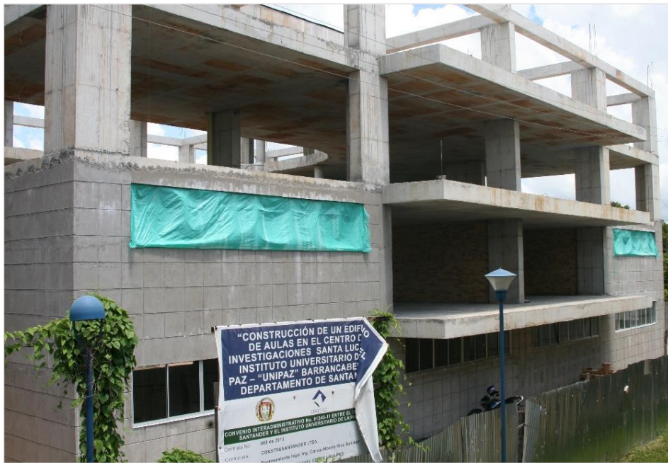
Figura 25. Proyecto de Construcción Edificio de Aulas.
