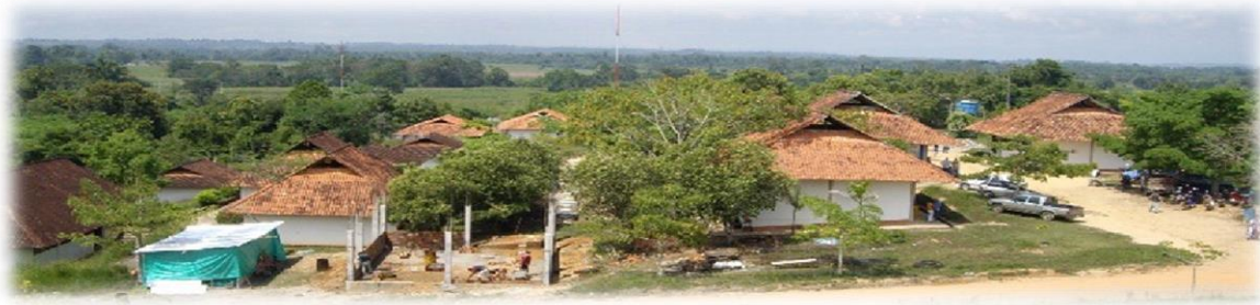
Figura 3 Etapa 1 de Construcción del Centro de Investigaciones Santa Lucía.
