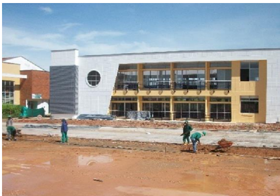
Figura 4 Etapa 3: Construcción del Edificio Administrativo y Plazoleta Principal.
