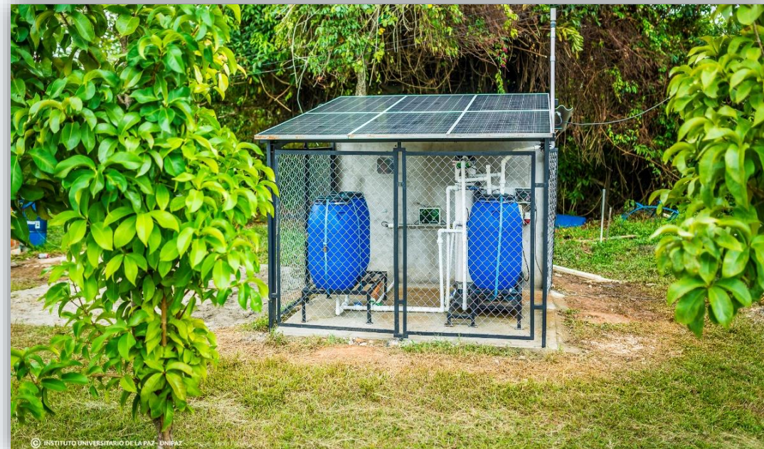
Proyecto planta potabilizadora de agua
